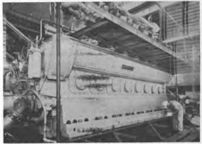
Workman pours resin chocks under 6,150-hp diesel.
