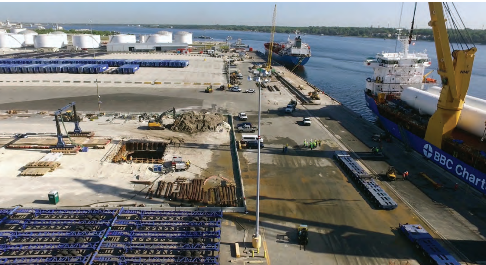
Credit: LNG bunker construction site
