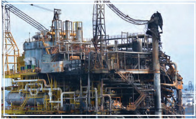
Pemex- Plataforma Abkatun A Permanente close-up.
