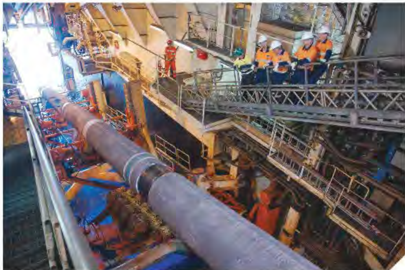
Installing the Ichthys LNG offshore gas export pipeline.
